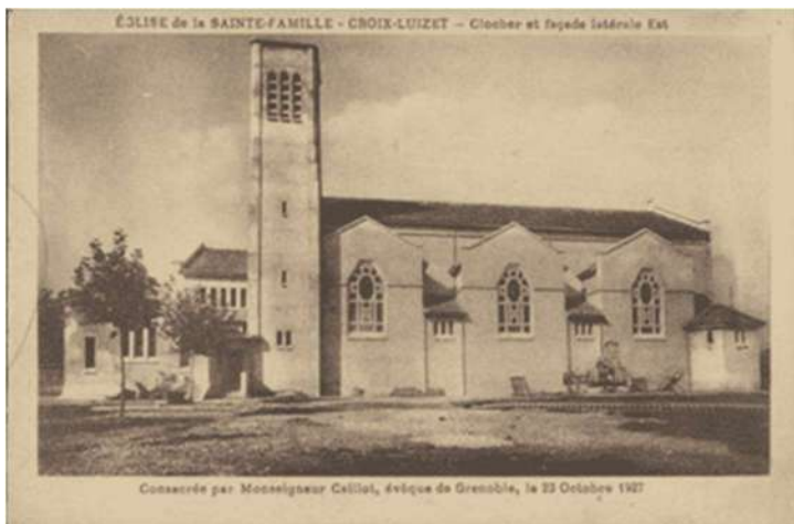
Vue côté est, avec clocher non terminé
